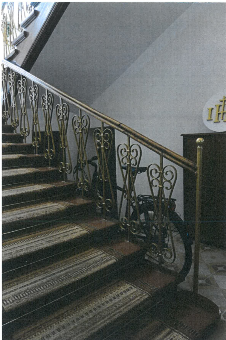
Fot.5.Zbliżenie wtórnego, parterowego słupka balustrady.
