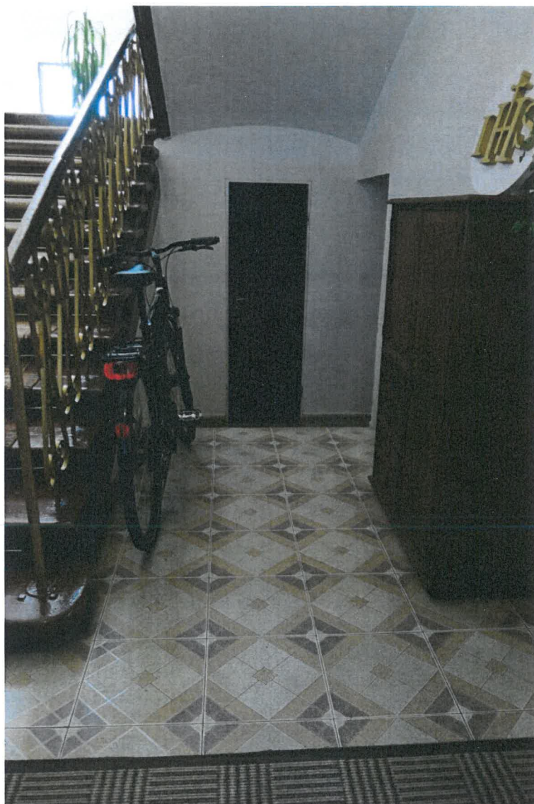
Fot.6. Widok ogólny klatki schodowej z poziomu parteru w kierunku zejścia do piwnicy.
