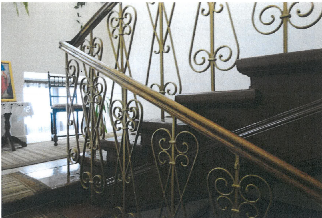
Fot.3. Zbliżenie balustrady na odcinku półpiętra.
