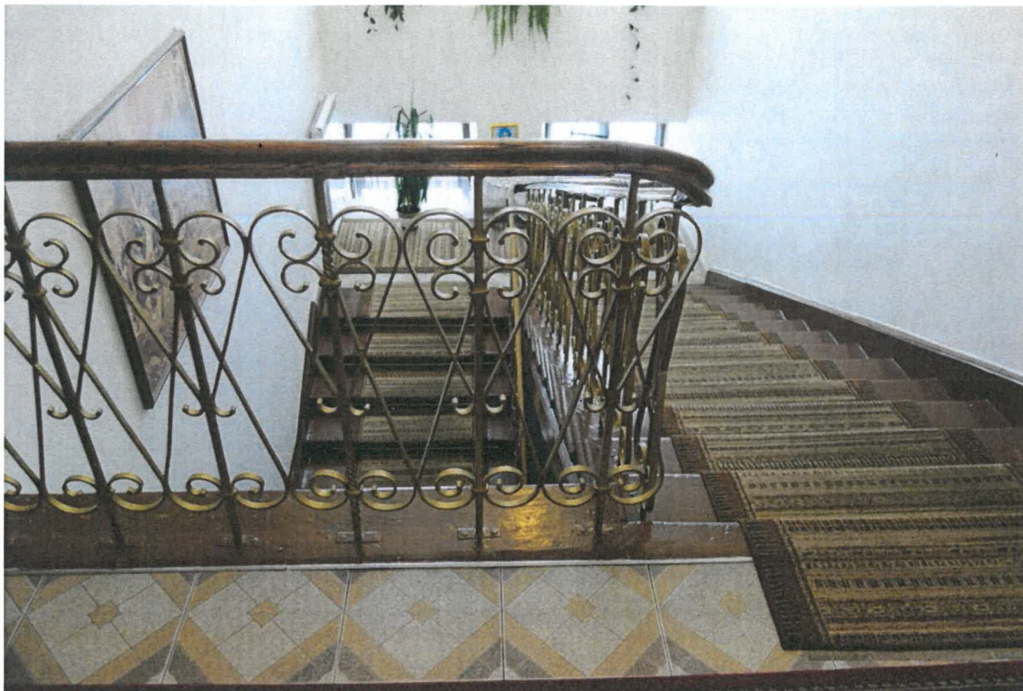
Fot.1. Klatka schodowa plebanii w ujęciu z korytarza piętra, z przodu balustrada zabezpieczająca.
